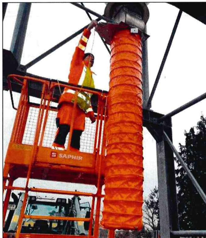
Außerdem hat das Bauhof-Team am Salz-Silo einen neuen höhenverstellbaren Auslass montiert. Derzeit werden das Bedienpodest und ein neuer Aufstieg nach den heutigen Richtlinien in Eigenleistung gefertigt.
